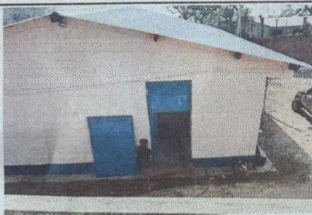
cambio de puerta en una aula
