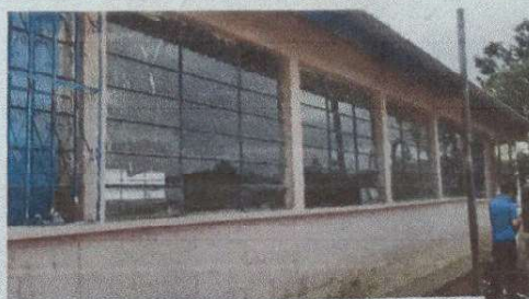
sistitucion de bidrios en ventanas de aulas.
