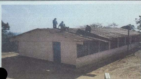
Inicio de cambio de lamina en techo de aulas y Direccion
