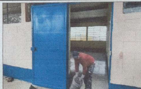
Trabajo de cambio de piso de concreto por ceramica
